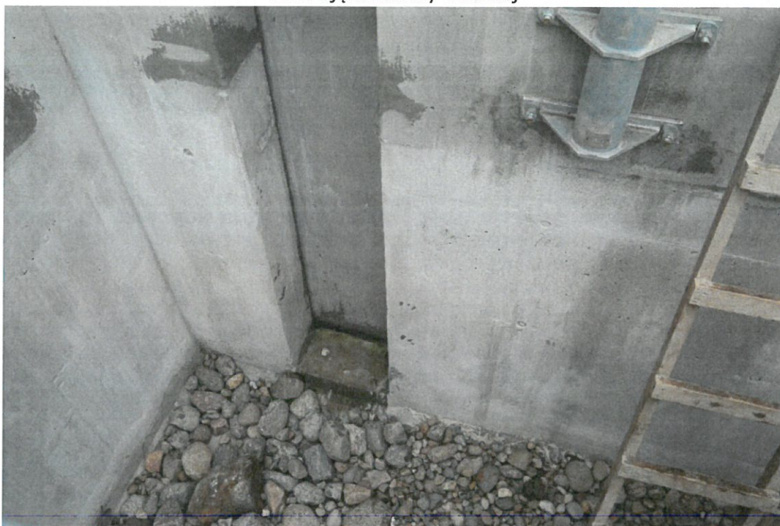
Fot. Zdjęcia komory wlotowej
