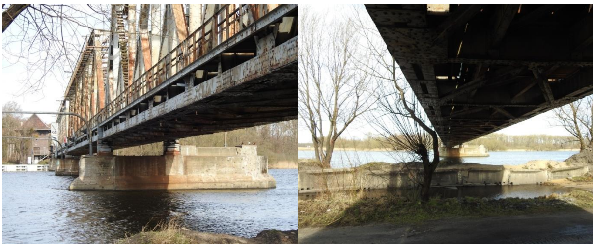
Fot. 15 i Fot. 16 Betonowe podpory mostu bez luk i wnęk
