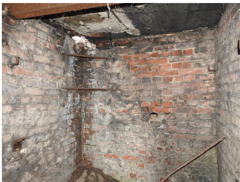
Fot. 14 Wnętrze byłego schronu, nie odnotowano siedlisk nietoperzy, małe ceglane pomieszczenie, w górnym lewym rogu dziura w stropie. Na środku ścian widoczne częściowo zasypane rury wentylacyjne – kontrolowane endoskopem
