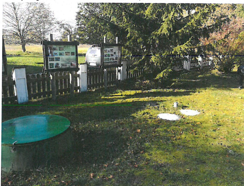
Fot. Istniejące złoża biologiczne oczyszczalni ścieków oraz separator osadów
