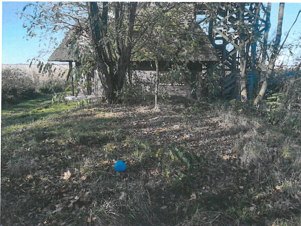
Fot. filtra piaskowego poziomego o powierzchni F=33\text{ m}^2
