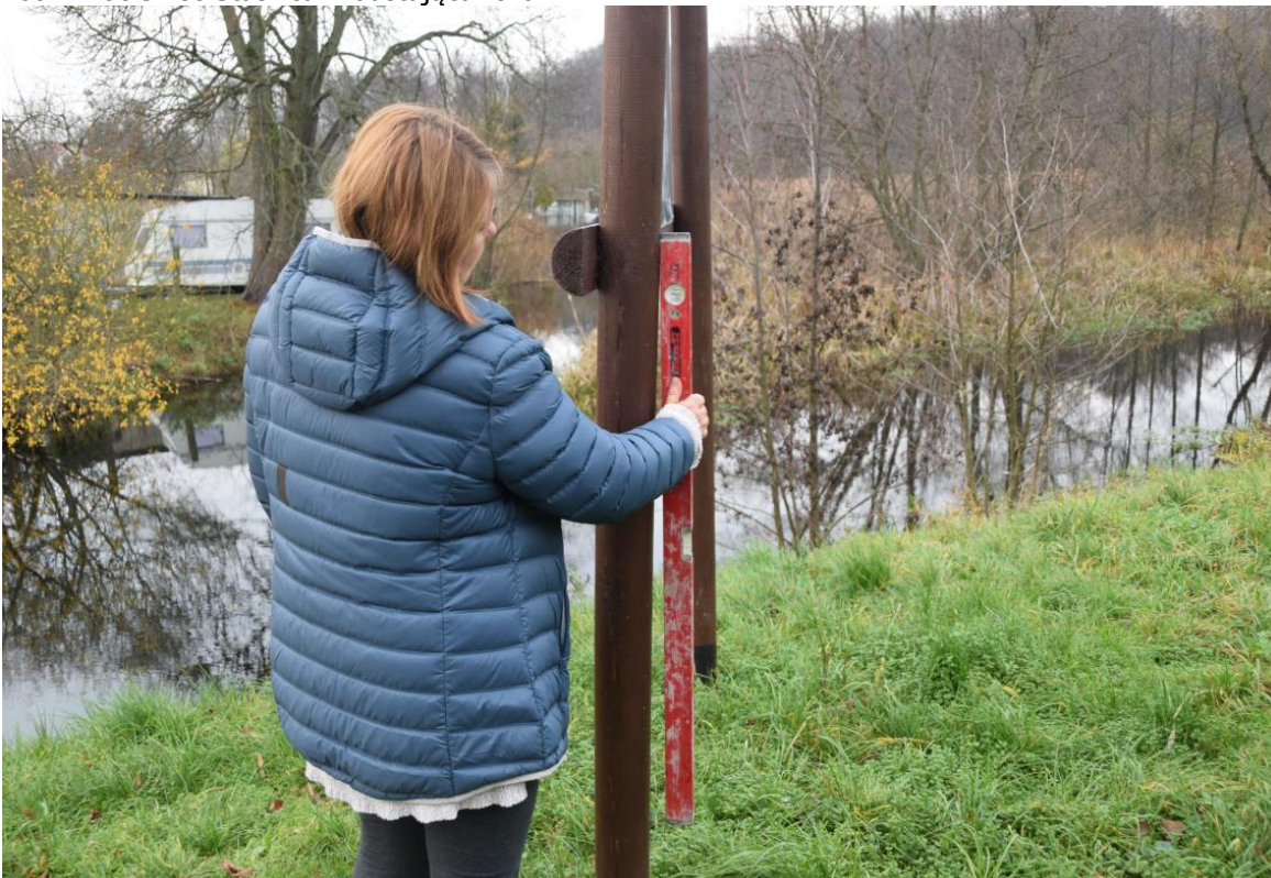
Fot.3 Złocieniec Staszica – brak pionu, niestabilne posadowienie tablicy.
