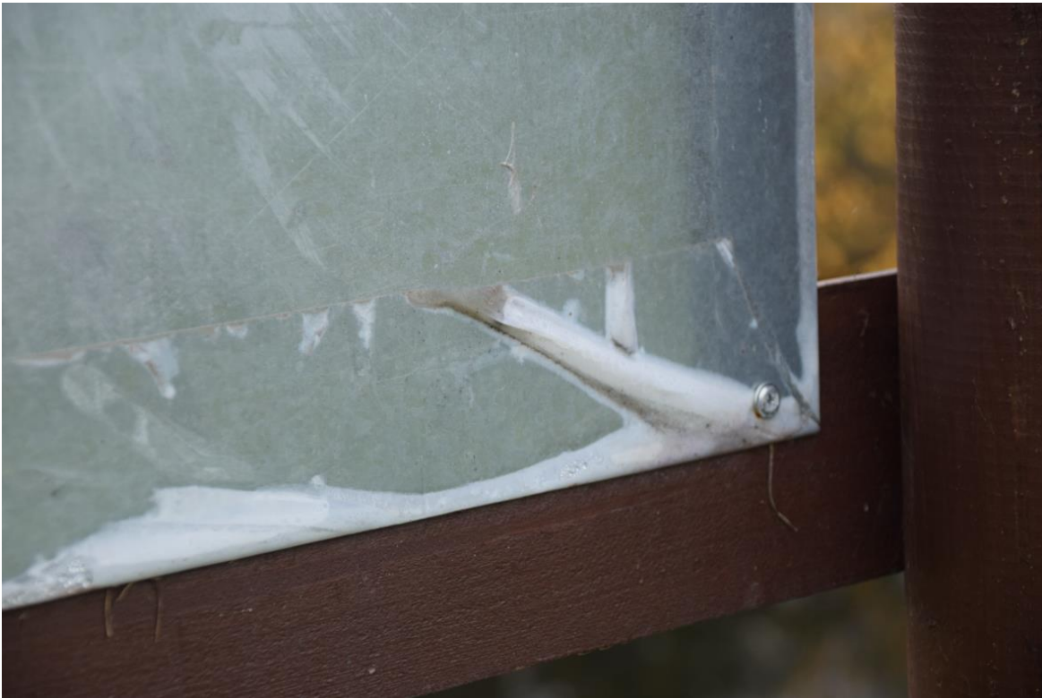
Fot.2 Złocieniec Staszica – odstająca folia.
