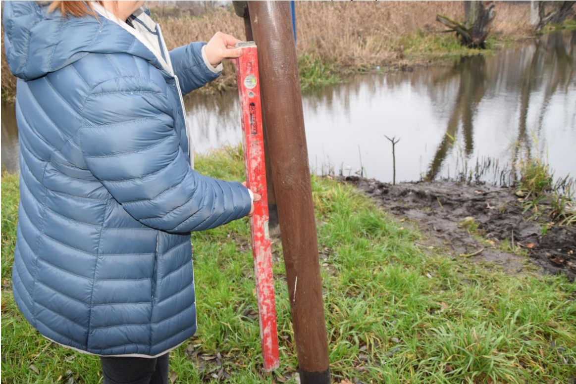
Fot. 6 Drawsko Pomorskie Koleśno – brak pionu, niestabilne posadowienie tablicy.
