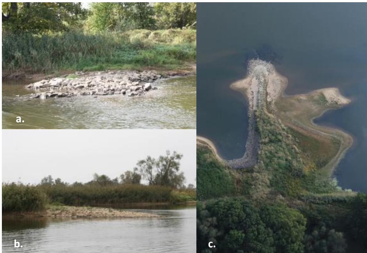
Abbildung 2: Buhnen an der Grenzoder a.) Defekte Buhne (615-09); b.) Intakte Buhne (610-15) und c.) Luftbild einer intakten Buhne bei Ratzdorf (Fotos: WSA Oder-Havel).
