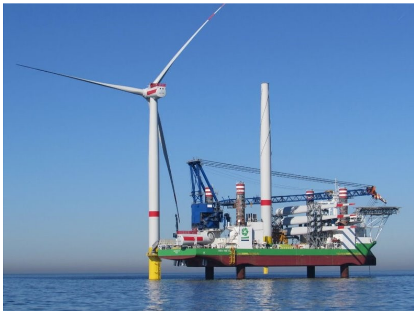
Rysunek 15. Montaż elektrowni wiatrowej z wykorzystaniem statku typu jack-up. Źródło: COWI
