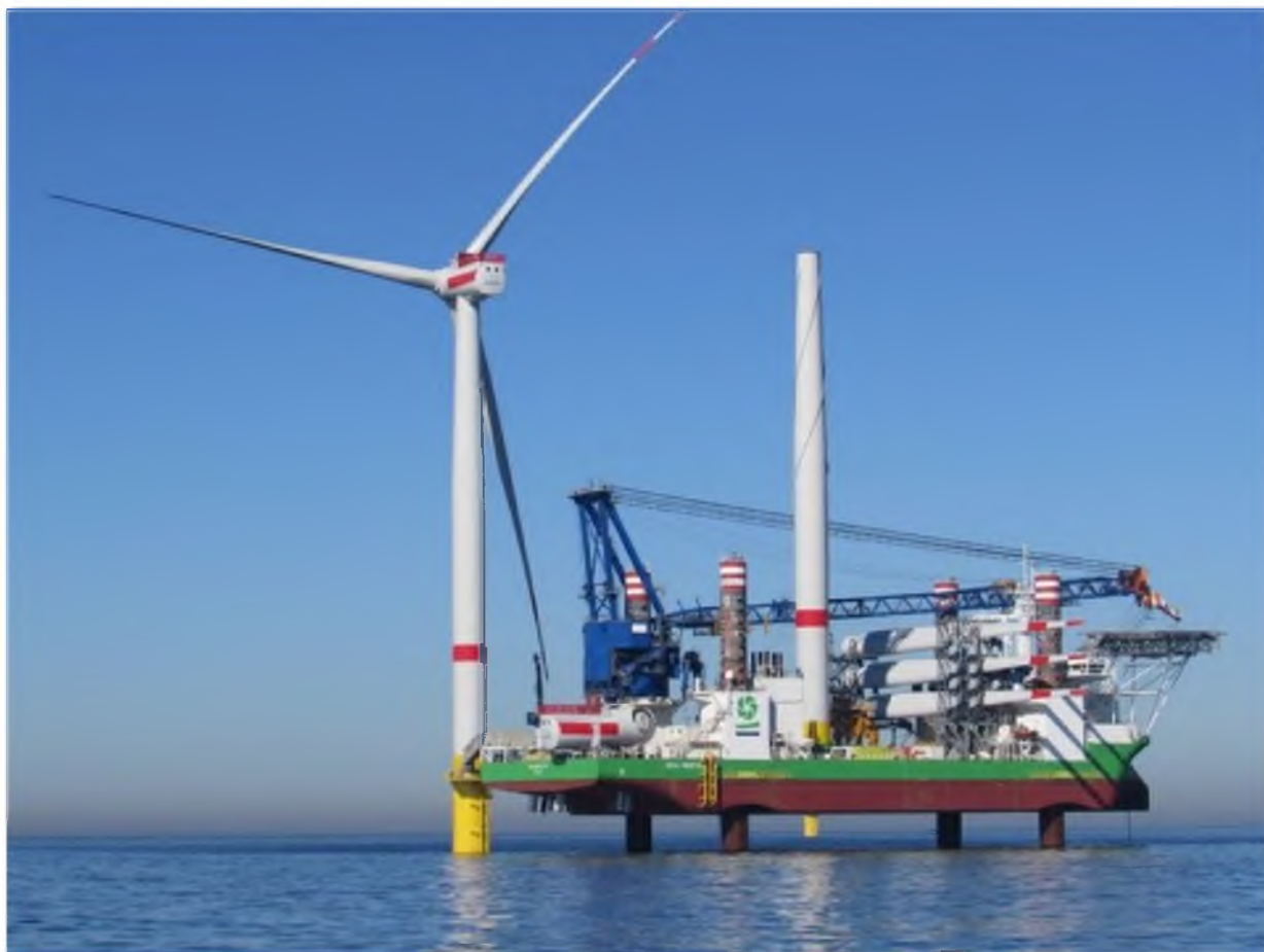
Rysunek 16. Montaż elektrowni wiatrowej z wykorzystaniem statków typu jack-up. Źródło: COWI
